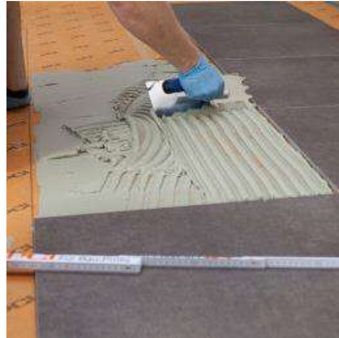
14. Auch die Verlegung der Bodenfliesen erfolgt, nach ausreichender Trocknungszeit, mit PCI Flexmörtel ® S2.
