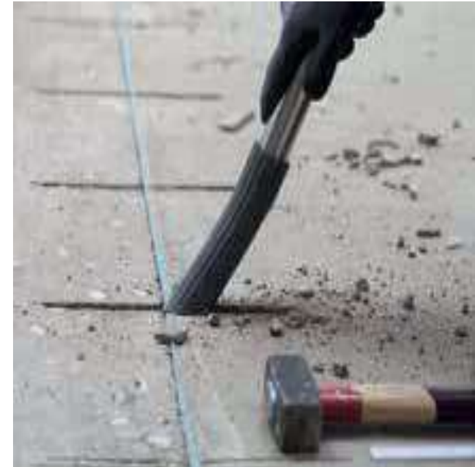
6. ...und lose Estrichreste mittels Industriestaubsauger abgesaugt.
