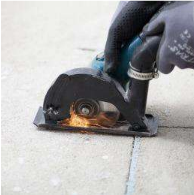
4. Anschließend werden diese Bereiche mit einem Trenn-schleifer eingeschnitten....
