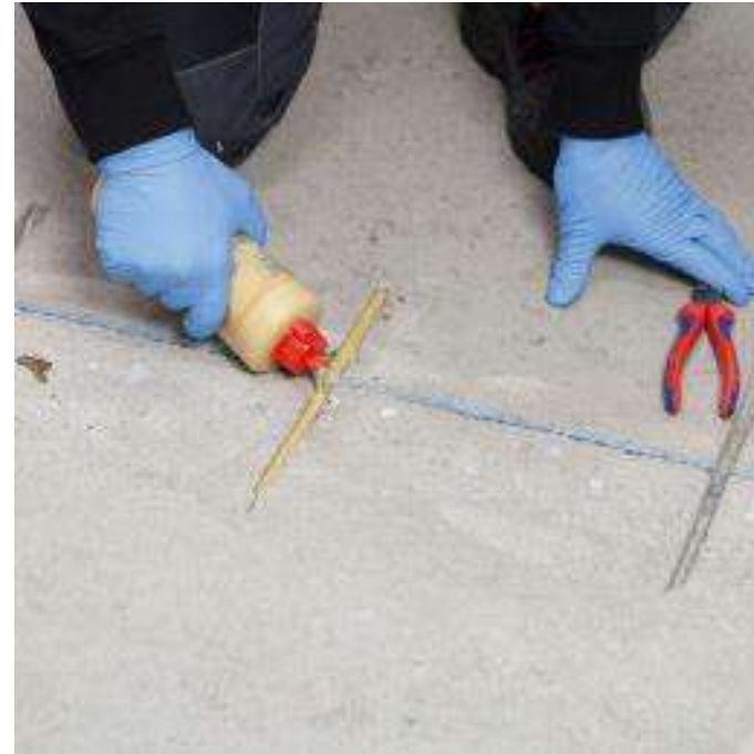
11. ...danach die Nut komplett mit PCI Apogel® SH aufgiessen...
