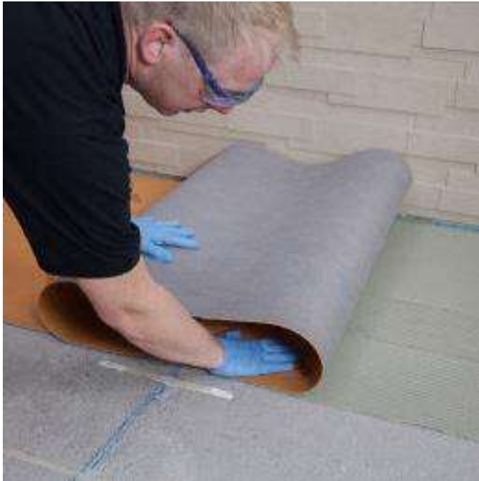
13. Nach ca. 40 Minuten wird PCI Pecilastic ® U mit PCI Flexmörtel ® S2 als Entkoppelungsschicht auf dem Estrich verklebt.
