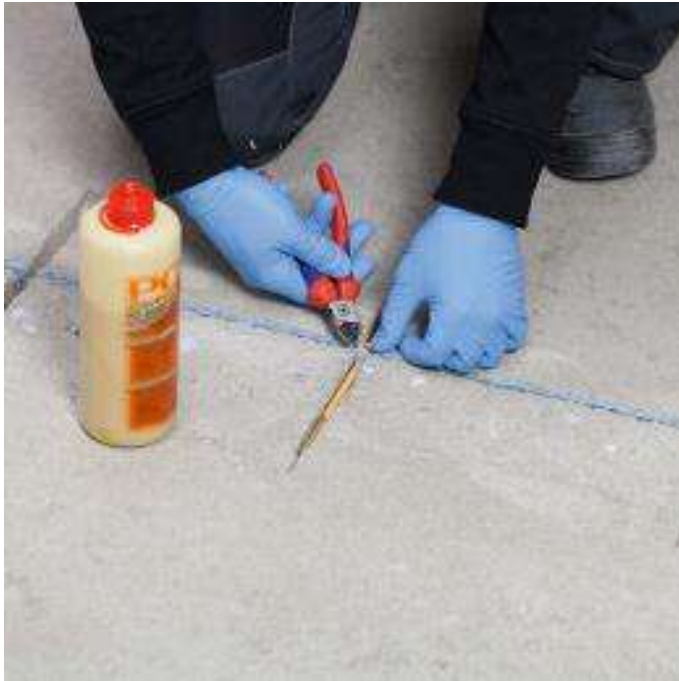
10. ...den PCI Apogel® Dübel in die Nut einlegen und den Spanning entfernen...
